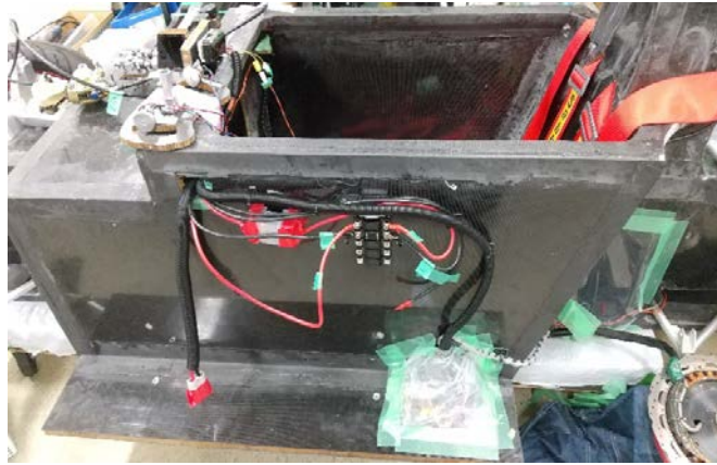
図 4 新車体への配線の実装
